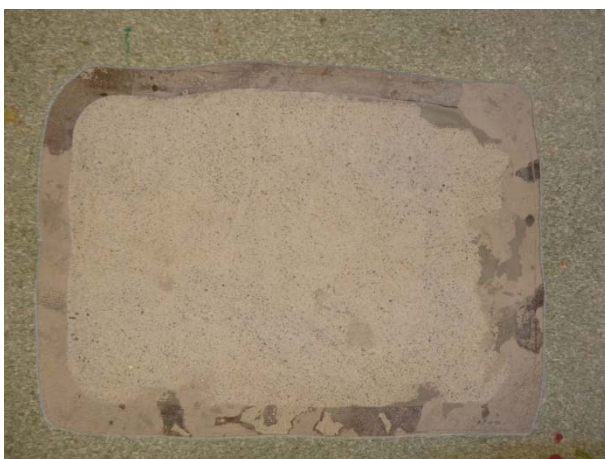
Bild: Renslipad betongyta 0,6 m * 0,8 m.
